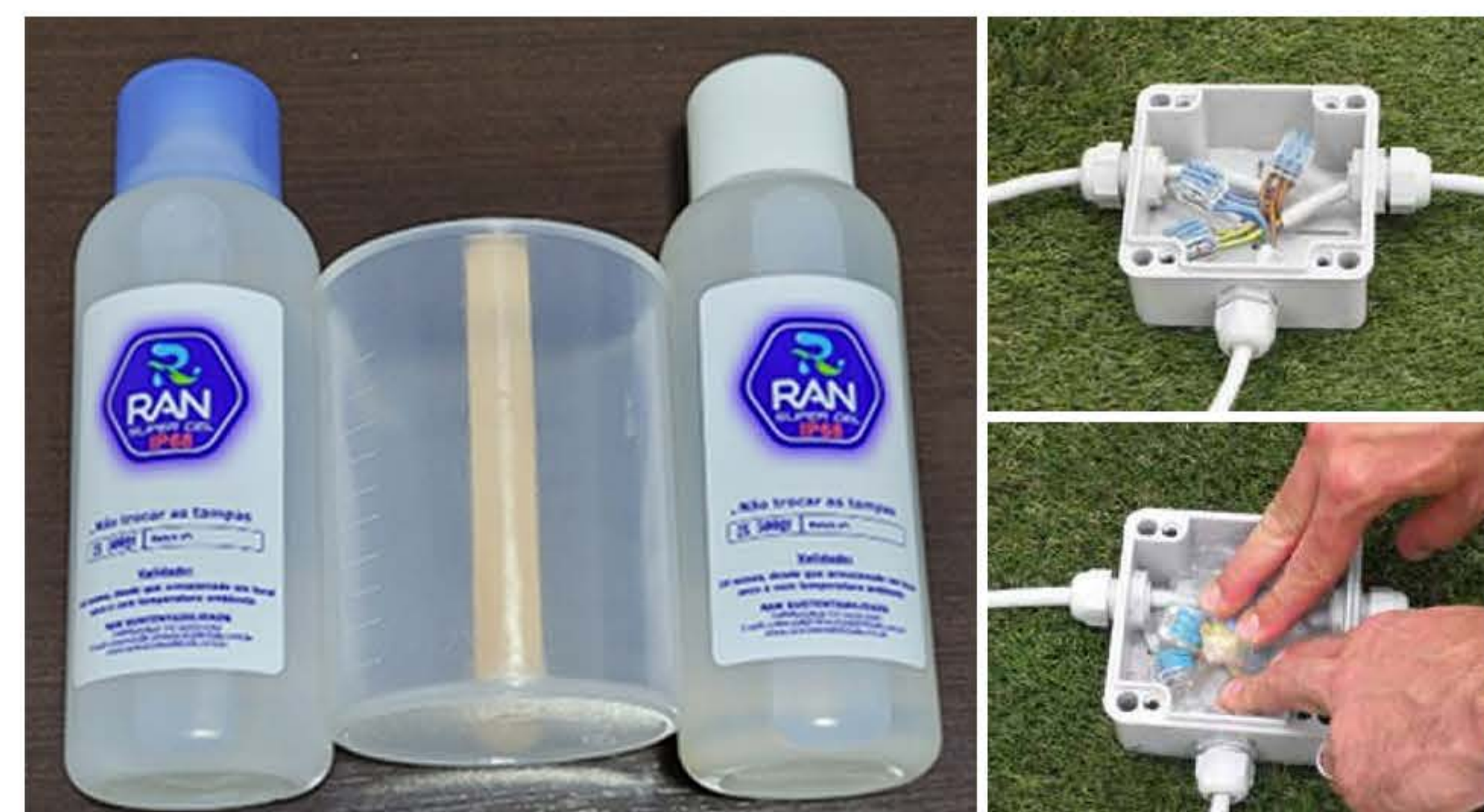
Exemplo de aplicação em caixa de passagem, cubrindo totalmente as conexões não criando espaços vazios entre os contatos.
